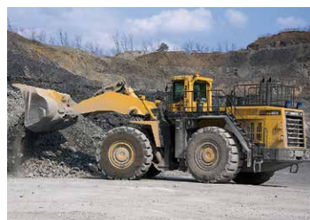
大型重機による掘削・積込作業(坂本沢地区)
