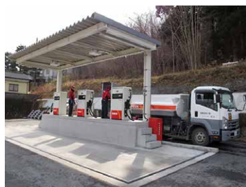
石油配送センター(陸上配送・海上給油) 大船渡油槽所 大船渡市大船渡町字猪頭117-1 TEL0192-25-1161・FAX0192-25-1163
