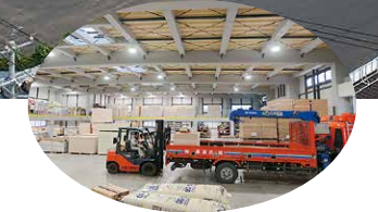
建材センター 作業風景
