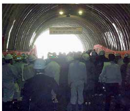
小石浜トンネル貫通式
