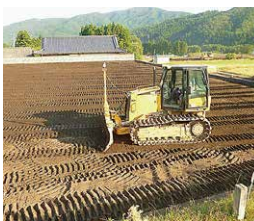
ほ場整備工事
